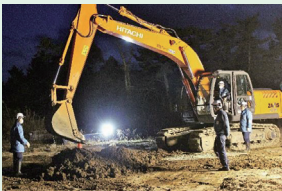
陥没箇所の埋め戻し
