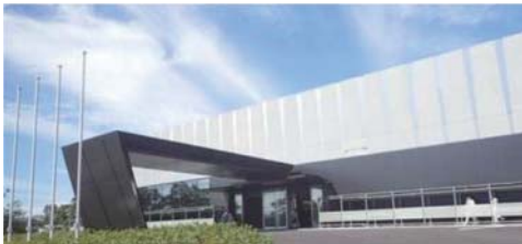
新事務本館外観
