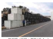
防潮堤（仮設：海抜15.4m）
