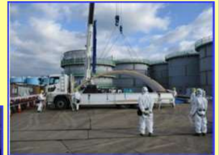
↑ 側板積込状況
