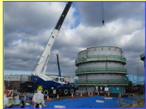
↑ 側板解体状況
