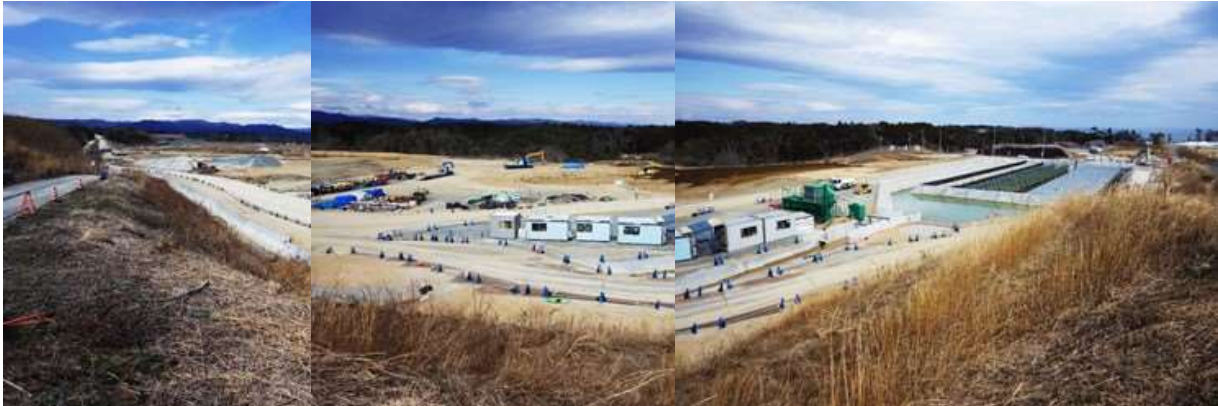
土捨て場北側土地造成工事
