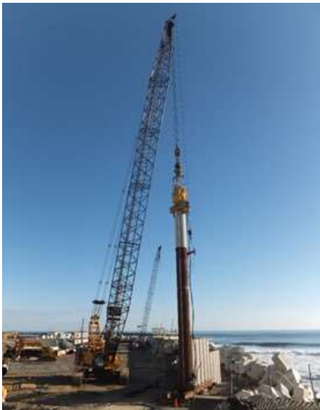
海側遮水壁設置工事
