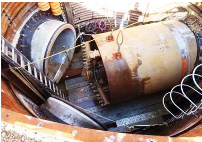
西側排水路新設工事
