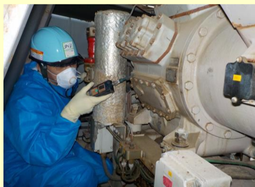
5・6号機の設備点検作業
