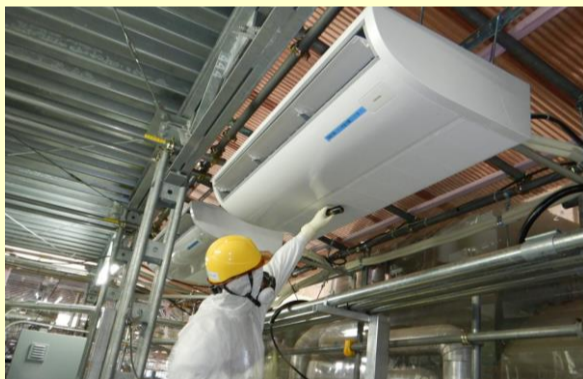
1～4号機の換気空調設備の設置作業
