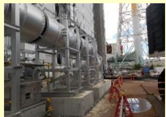
3号機の換気空調設備の設置作業
