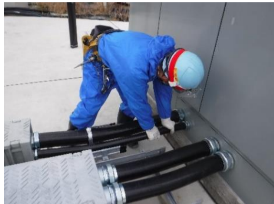
ケーブル布施作業(電気)
