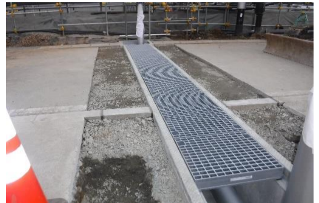
配管敷設溝(土木)
