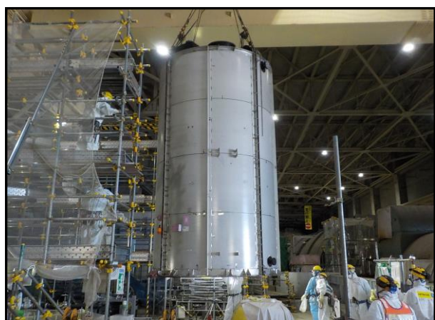
4号機への 建屋内RO濃縮水受けタンク設置
