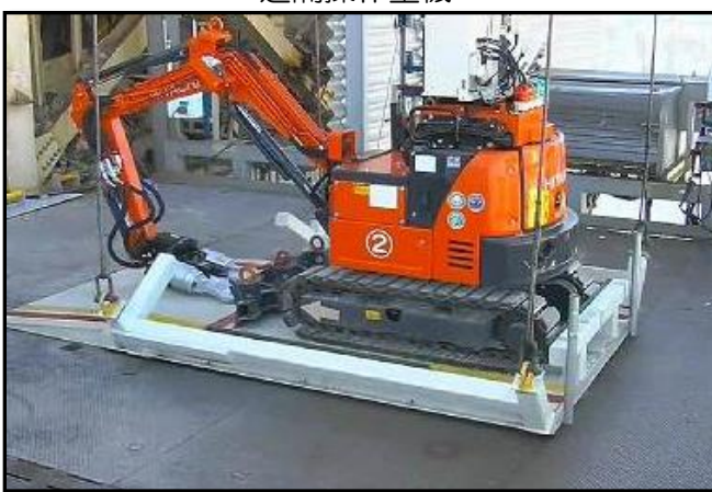
1号機R/Bオパフロ西側瓦礫撤去用 遠隔操作重機
